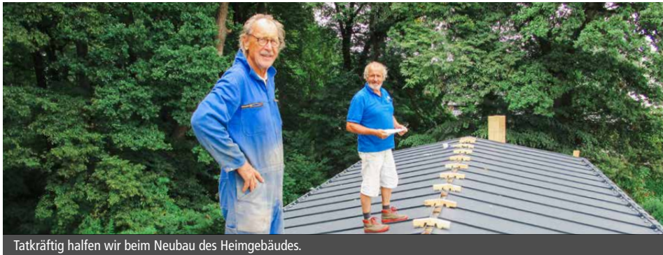
Tatkräftig halfen wir beim Neubau des Heimgebäudes.
